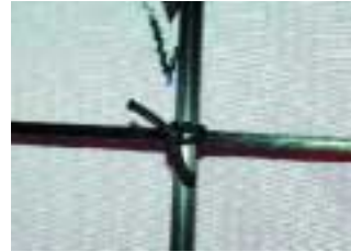
Spreizstab am Mittelstab befestigt
